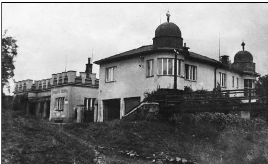
Starší pohled na bývalou stáčírnu a obytnou část objektu Hedva.
